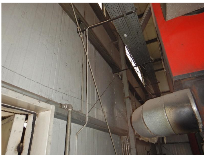
Fot. 6 Widok czopucha kotła do modernizacji
